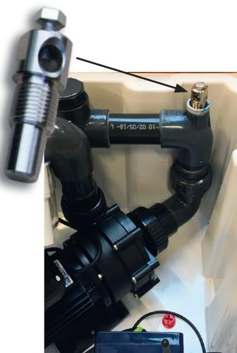
L'eau est aspirée à la surface de la piscine par les skimmers et arrive à la pompe qui la rejette après avoir traversé les cartouches filtrantes et s'être débarrassée de toutes impuretés qu'elle contenait, l'eau retourne ensuite dans la piscine par la buse de refoulement. Après plusieurs cycles de filtration, il est nécessaire de procéder à un lavage des cartouches filtrantes.
