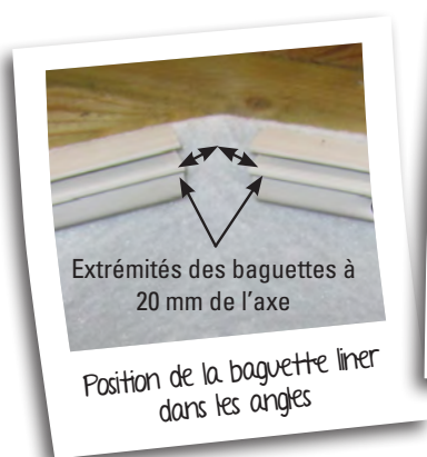
Positionnement des baguettes sur un même pan
