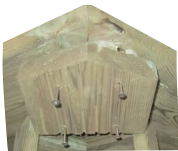
Fixation de la plaque sous margelles
