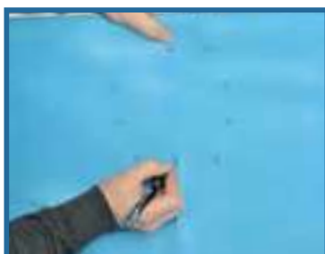
Repérez et tracez l'emplacement des vis.
