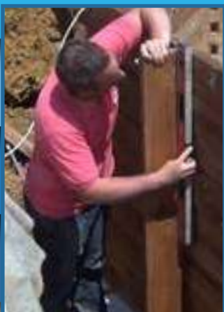
Contrôlez l'aplomb des renforts.
