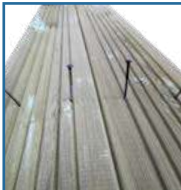
Fixation des margelles
