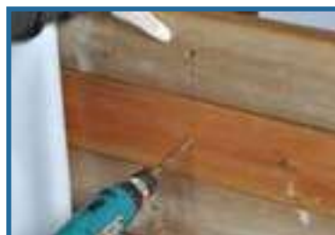
Fixez les consoles avec les vis de 6 x 90 (1 vis par madrier)
