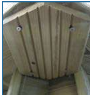
Fixation de la plaque sous margelles.
