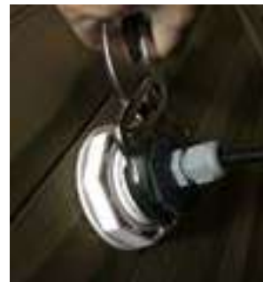
Serrez le raccord à l'aide d'une pince
